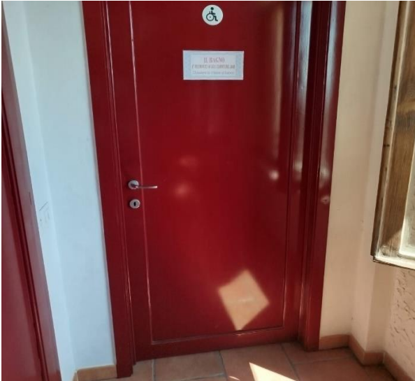
37 exterior door Toilet
